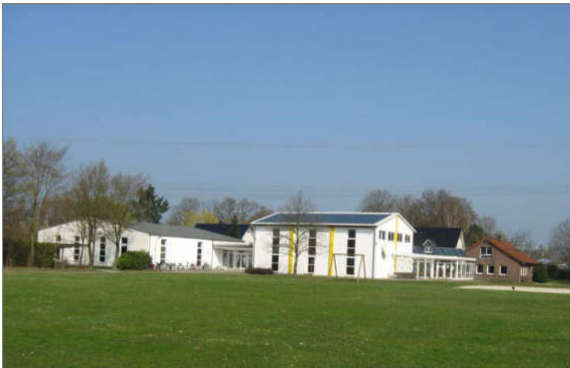
Sportanlage des SC Borgfeld
