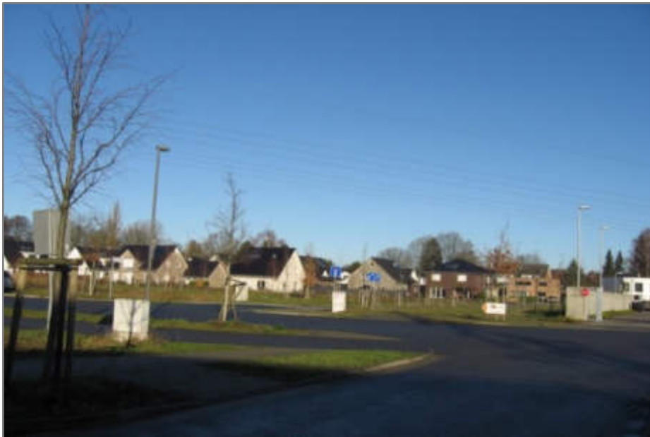
Hamfhofsweg nach Fertigstellung...
